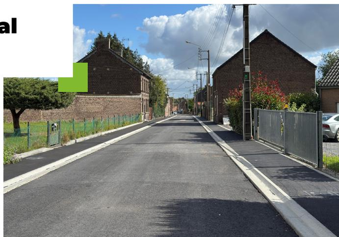
Les travaux ont porté à la fois sur les réseaux souterrains et sur la surface. Le réseau d'eau potable et celui d'assainissement ont été intégralement remplacés. La voirie, les bordures, les trottoirs et les caniveaux ont, eux aussi, été refaits à neuf. Enfin, l'éclairage public bénéficiera dans quelques semaines d'une technologie LED, plus économe et plus respectueuse de l'environnement.
